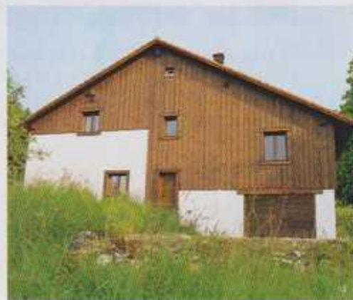
Une façade sobre et généreuse, percée de rares fenêtres de taille différentes. L'emplacement non aligné des ouvertures laisse deviner qu'à l'intérieur, tout se joue par demi-niveaux.
